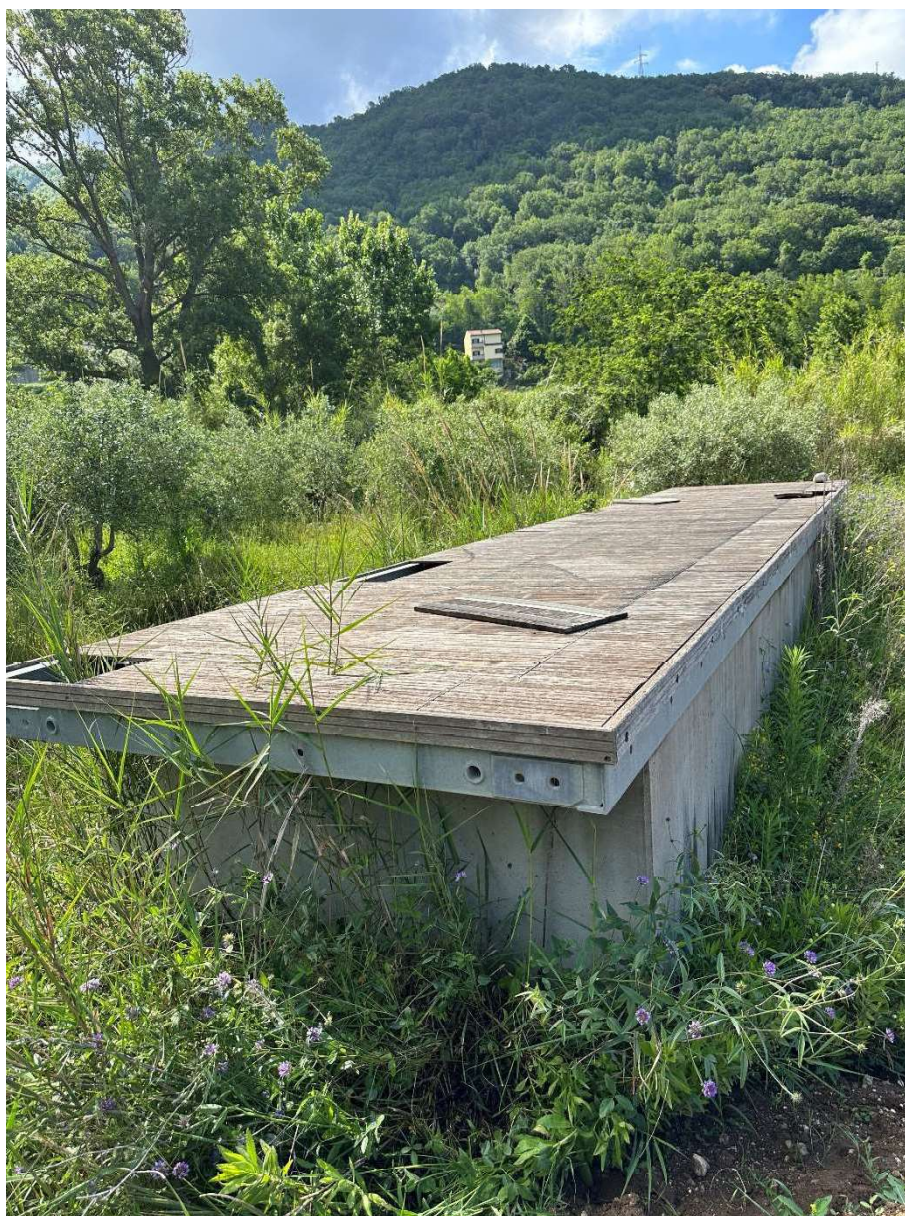
Foto 8: Pontile a galleggiamento continuo dim. 12 x 2,50 mq con telaio rinforzato in acciaio zincato a caldo con galleggianti monoblocco.
